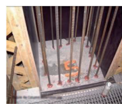
Verlenging van kolommen met overlappingslassen
