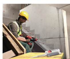
Eindverankering van trap aan muur
